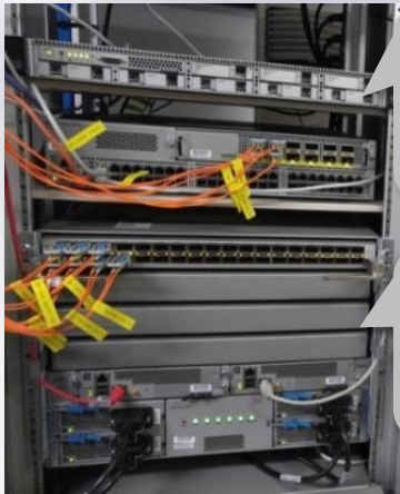
데이터센터 SDN Controller (Cisco APIC) 1,000 고객 수용, 3중화
